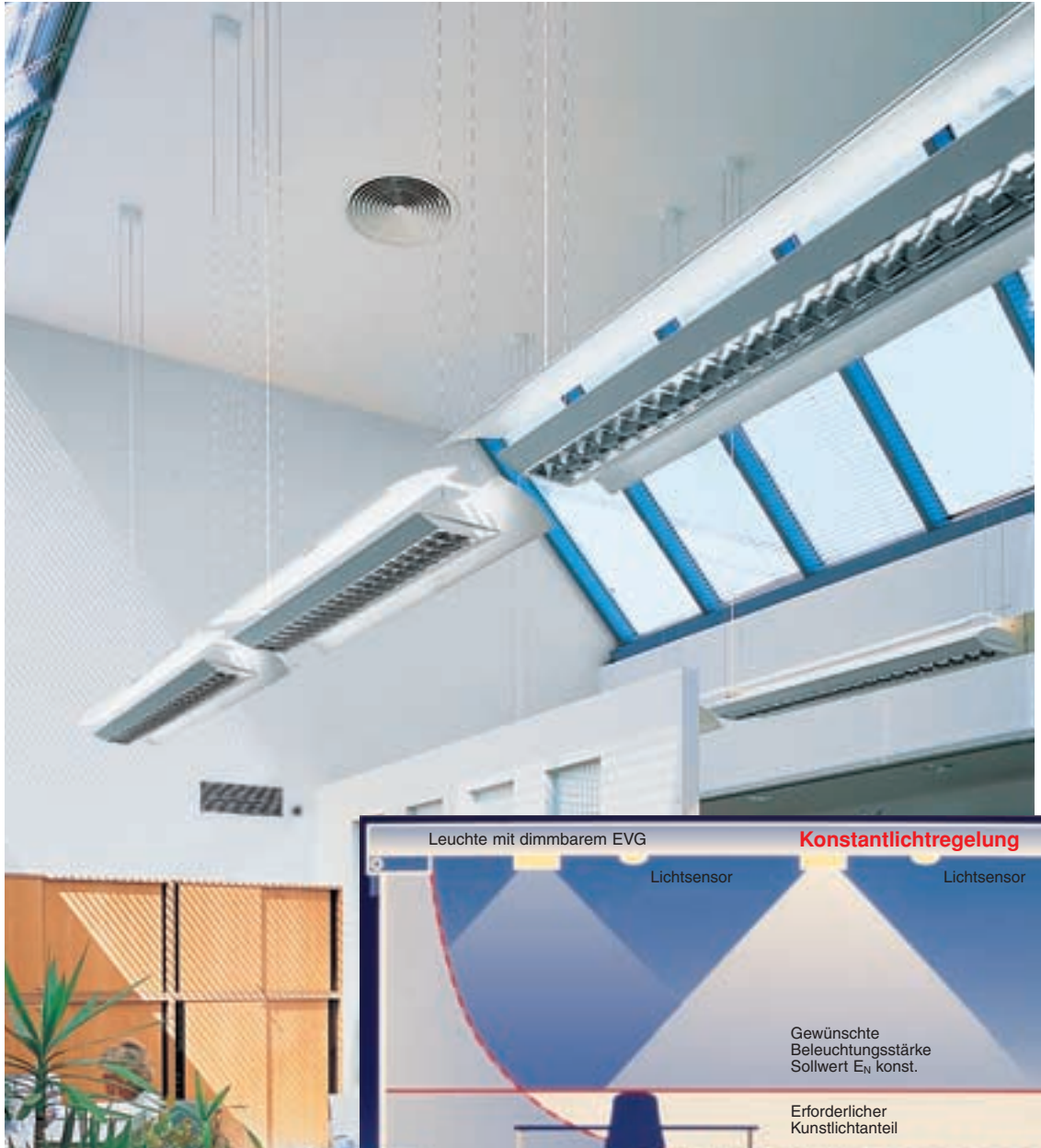
Bild 10: Steht für das notwendige Beleuchtungsniveau genügend Tageslicht zur Verfügung, schaltet sich die Beleuchtung automatisch ab.
