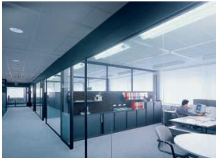
Bild 6: ...tagsüber kann das Licht der Leuchten an der Fensterfront dunkler gedimmt oder – wie hier – ausgeschaltet werden. Lichtsensoren automatisieren diesen Vorgang.
