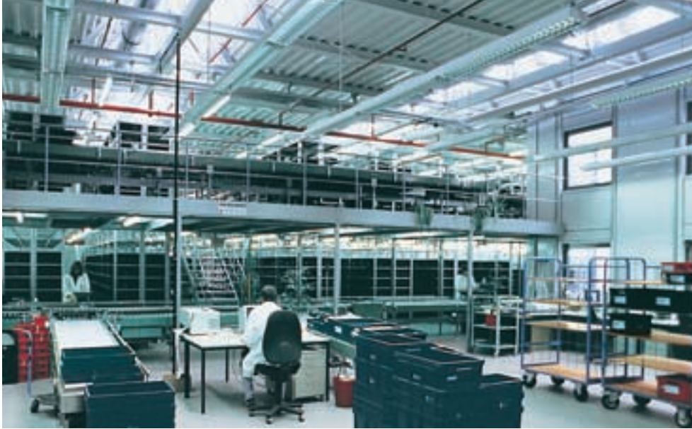
Bild 14: Gleichmäßiger Tageslichteinfall durch das Sheddach – ideale Voraussetzung für eine Konstantlichtregelung
