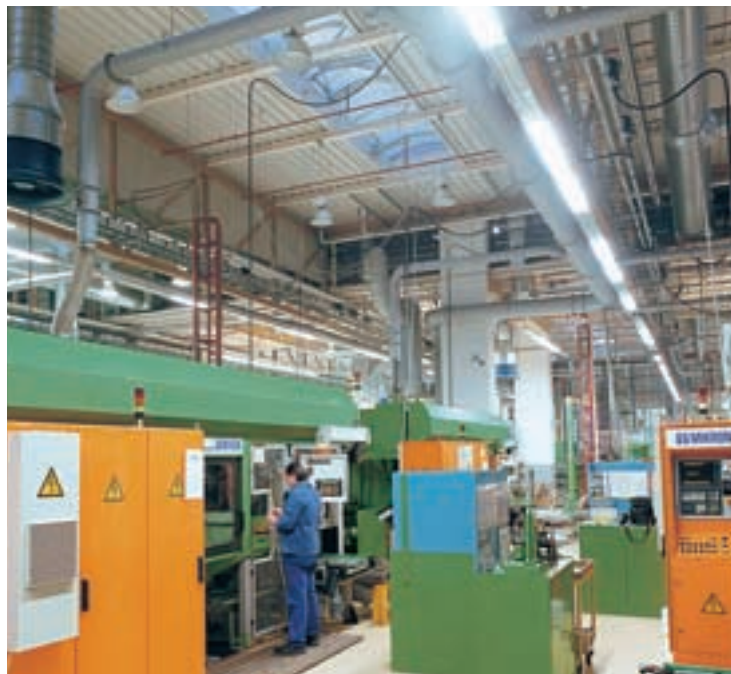
Bild 12: Eine Konstantlichtregelung spart im Vergleich zu unregelmäßigem Betrieb mit elektronischen Vorschaltgeräten (EVG) mindestens die Hälfte der Energie.
